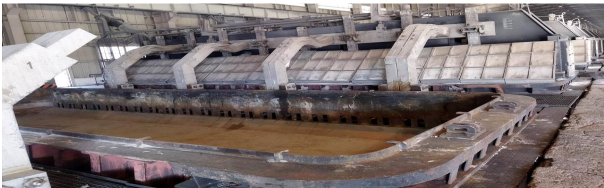
Şəkil 2. Gəncə Alüminium Kompleksində əsaslı təmir üçün sökülmüş və istehsalda olan elektroliz vannaları.
